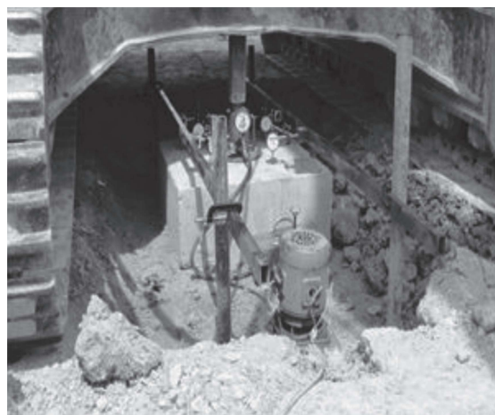
Hình 7: Thí nghiệm nén tĩnh hiện trường
